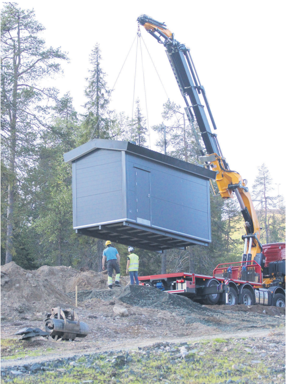
Pumppaamorakennus asennetaan paikoilleen.
